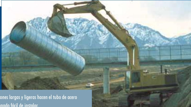
Secciones largas y ligeras hacen el tubo de acero corrugado fácil de instalar.
