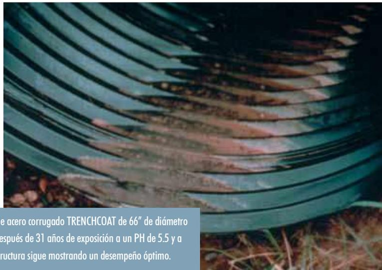
Instalada en 1975, esta tubería de acero corrugado TRENCHCOAT de 66" de diámetro esta en excelentes condiciones. Después de 31 años de exposición a un PH de 5.5 y a una abrasión moderada, esta estructura sigue mostrando un desempeño óptimo.
